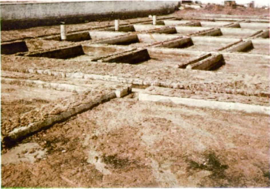
La actual depuradora de Mula, colmatada de materiales sólidos, evidencia su inutilidad.
