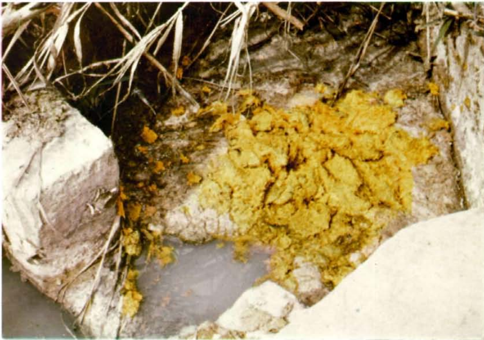
En la poceta de descarga al río Mula de la Acequia de las Tapias, se aprecian los residuos de pulpa de naranja que pone de manifiesto la incidencia de la contaminación de origen industrial.
