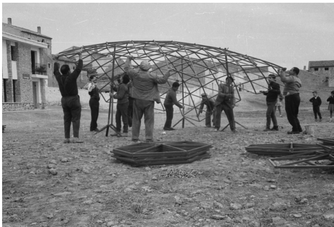
Figura 4. Montaje de la estructura Cúpula rebajada desplegable en Calasparra (1962). © Fundación Emilio Pérez Piñero.
