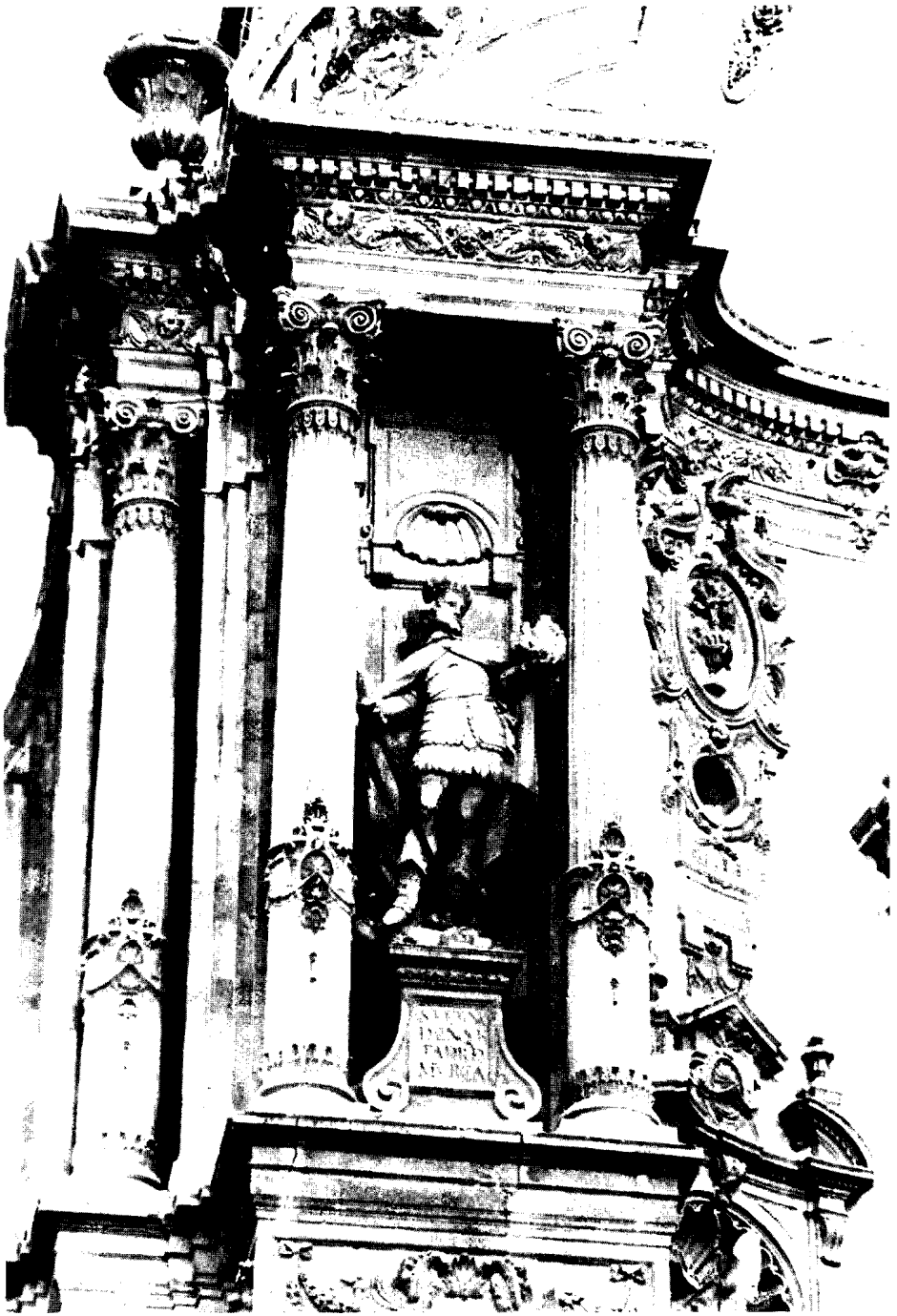
Lámina 6. Vicente Bort? San Fernando. Catedral de Murcia. Fachada. Detalle. 1748-1749.
